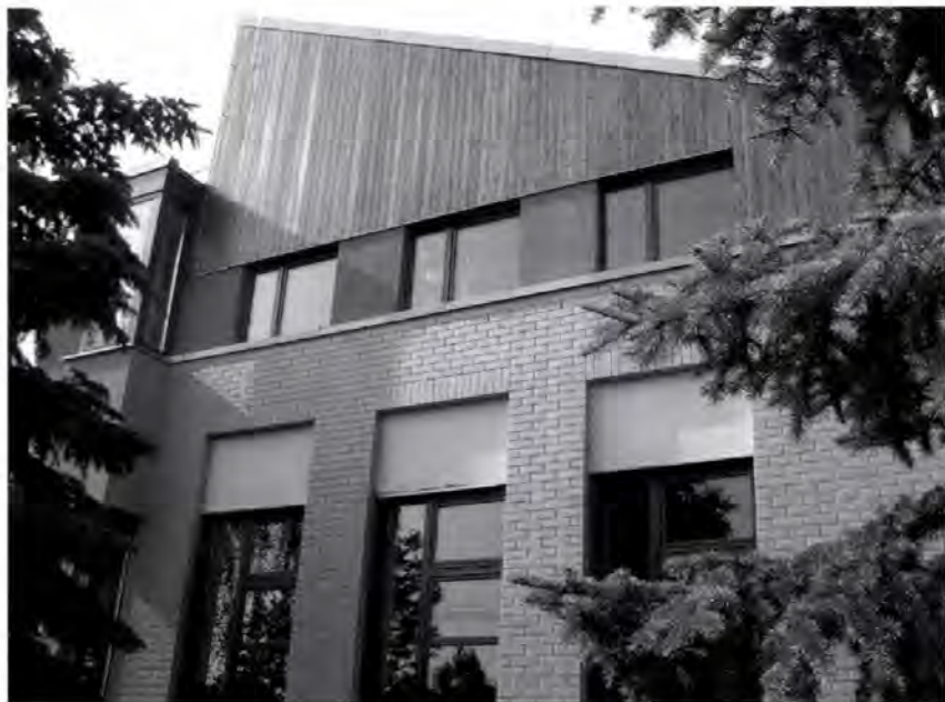
4. ábra. Új épületszárny részlete
