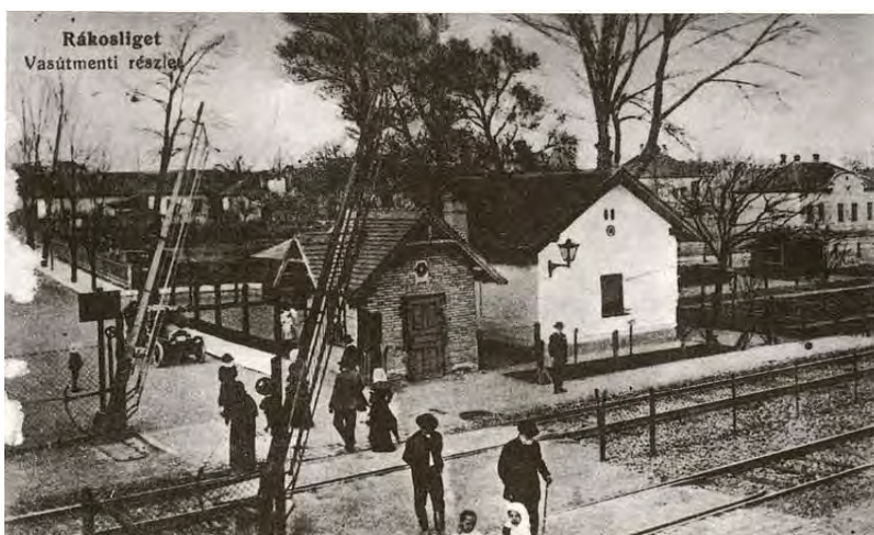
A 10. számú őrház épülete
